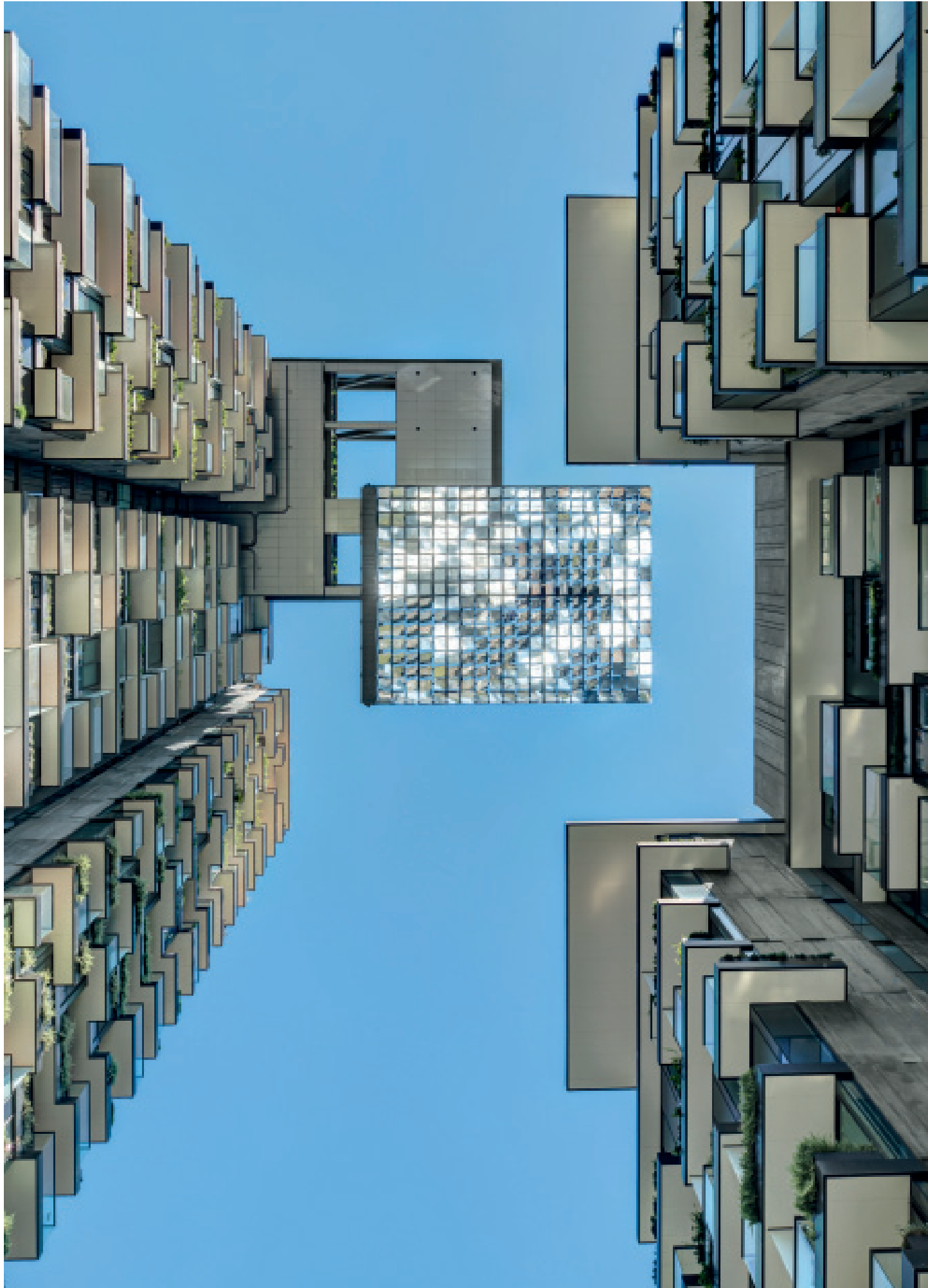
An der ausragenden Terrasse wurde ein Heliostat abgehängt, der Tageslicht auf und in die unteren, durch die Türme verschatteten Bauteile lenkt.
