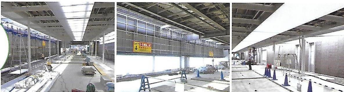
壁面にフレームを組み、特製合成フェルトを設置。
